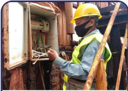
Proyek Lampu NPK
