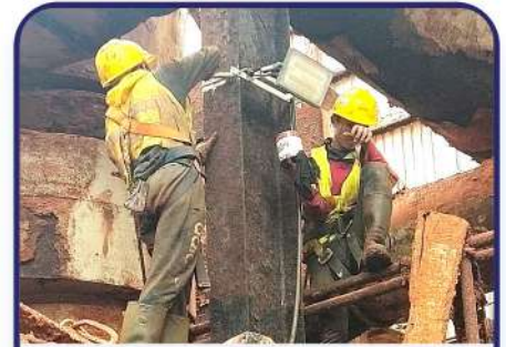
Proyek Lampu NPK
